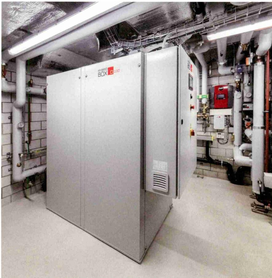
Die Hybridbox ermöglicht die Abdeckung des Wärmebedarfs für Heizen, Warmwasser, Gebäudekühlung und Abwärmenutzung mit einer einzigen Anlage. Beim Projekt «Bauen 2050» in Urdorf für 39 Wohnungen.
