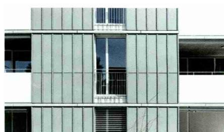
Fassade mit Photovoltaik-Modulen.
