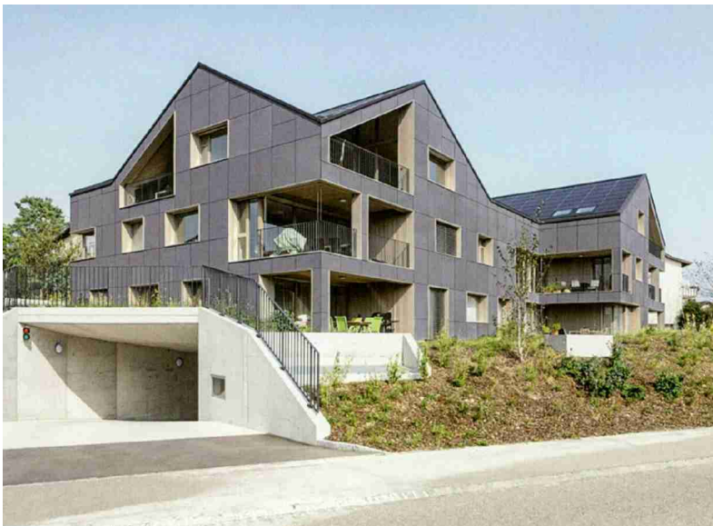
Das Dach und die Fassade des energieautarken Mehrfamilienhauses sind mit 1000 Quadratmeter Photovoltaik-Zellen bedeckt.
