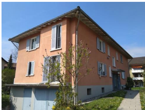
Vorher, Gebäude aus dem Jahr 1956
