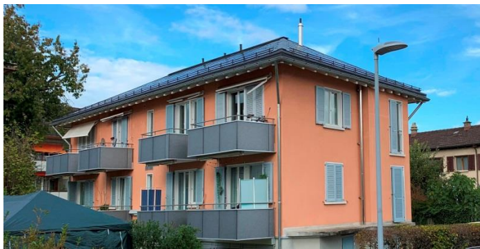
Nachher: Photovoltaik-Module als Balkonverkleidung
