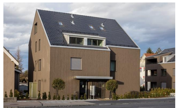
Bildlegende: Überbauung Affolternstrasse, Regensdorf
