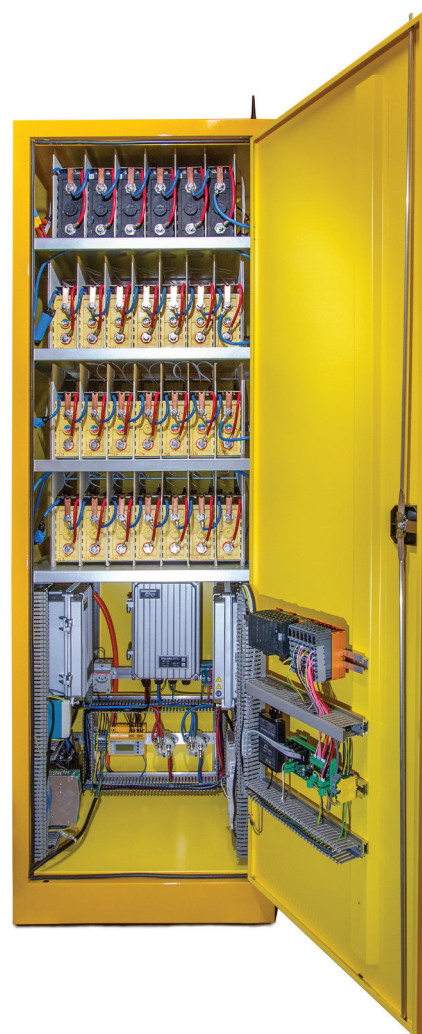
Second-Life-Speicher mit 10 kWh Speicherkapazität. Im Schrank haben maximal 4 x 8 Zellen Platz, die in Serie geschaltet werden. Foto: Ökozentrum Langenbruck
