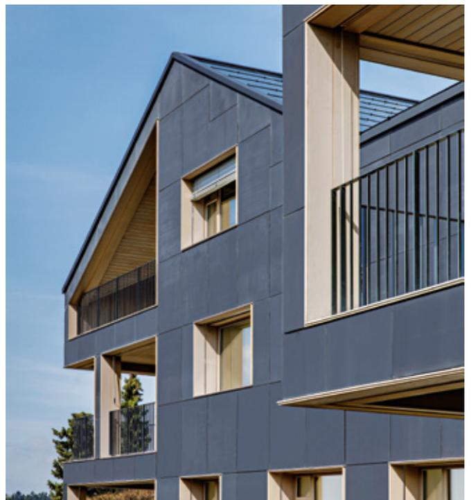
Detail Fassade mit eingeschobenen Loggien und Fensteröffnungen – die gesamte Gebäudehaut liefert Sonnenstrom und sorgt mit denen in Holz ausgekleideten Loggien und Fensterleibungen für eine elegante Architektursprache
